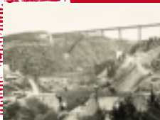
Chantier du pont de la N9 avant la mise en eau du barrage
