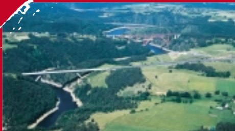
Le viaduc et le pont autoroutier de Garabit
