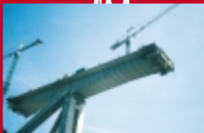
Construction du pont autoroutier
