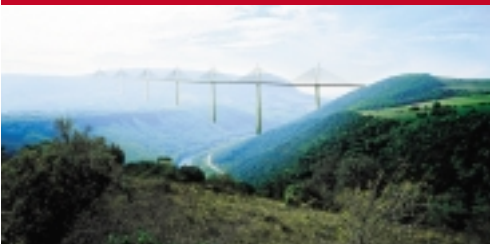
Le viaduc de Millau, le petit-fils de Garabit
