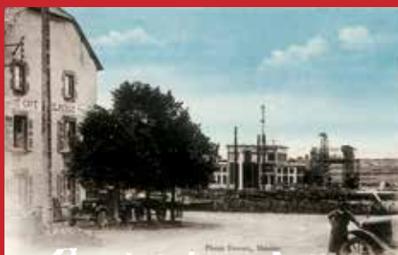
Poste de transformation, gare de Talizat
