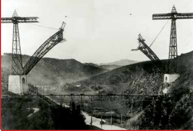
Un viaduc en pleine croissance
