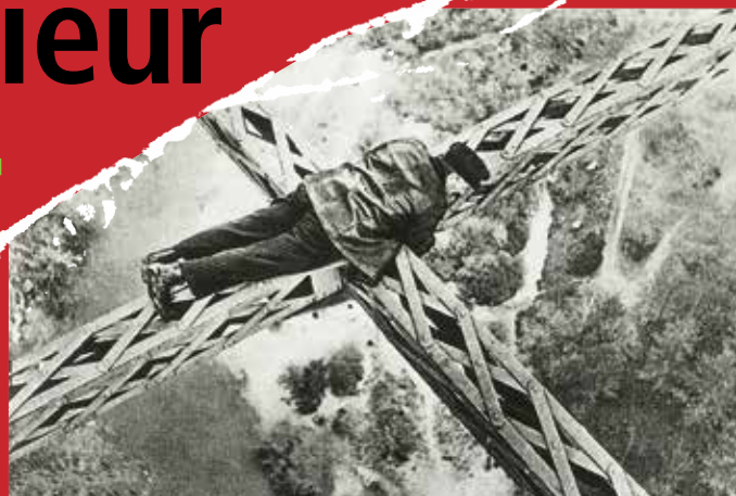
Monsieur Valadier en plein travail à 122 m du sol
