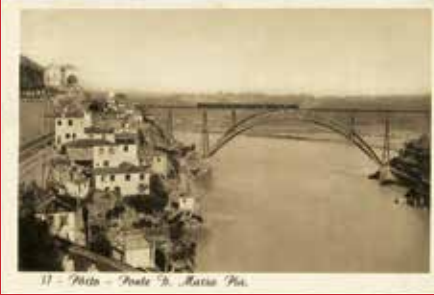
Viaduc Maria Pia sur le Douro
